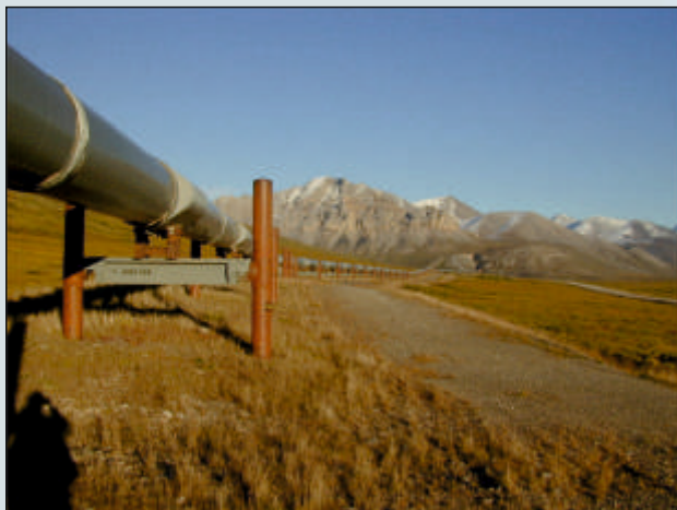
Монтаж трубопроводов на буропускных сваях
