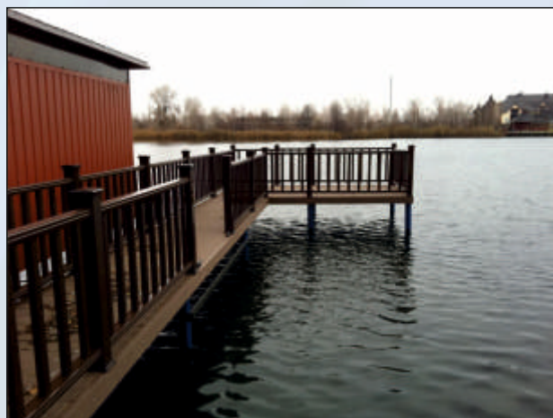
Монтаж пристани на винтовых сваях
