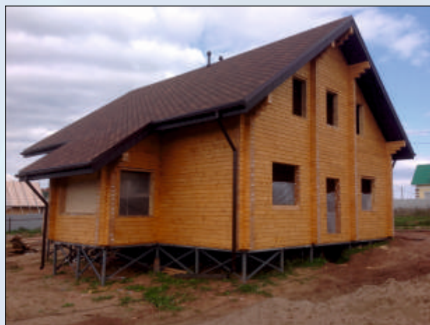
Монтаж деревянного дома
